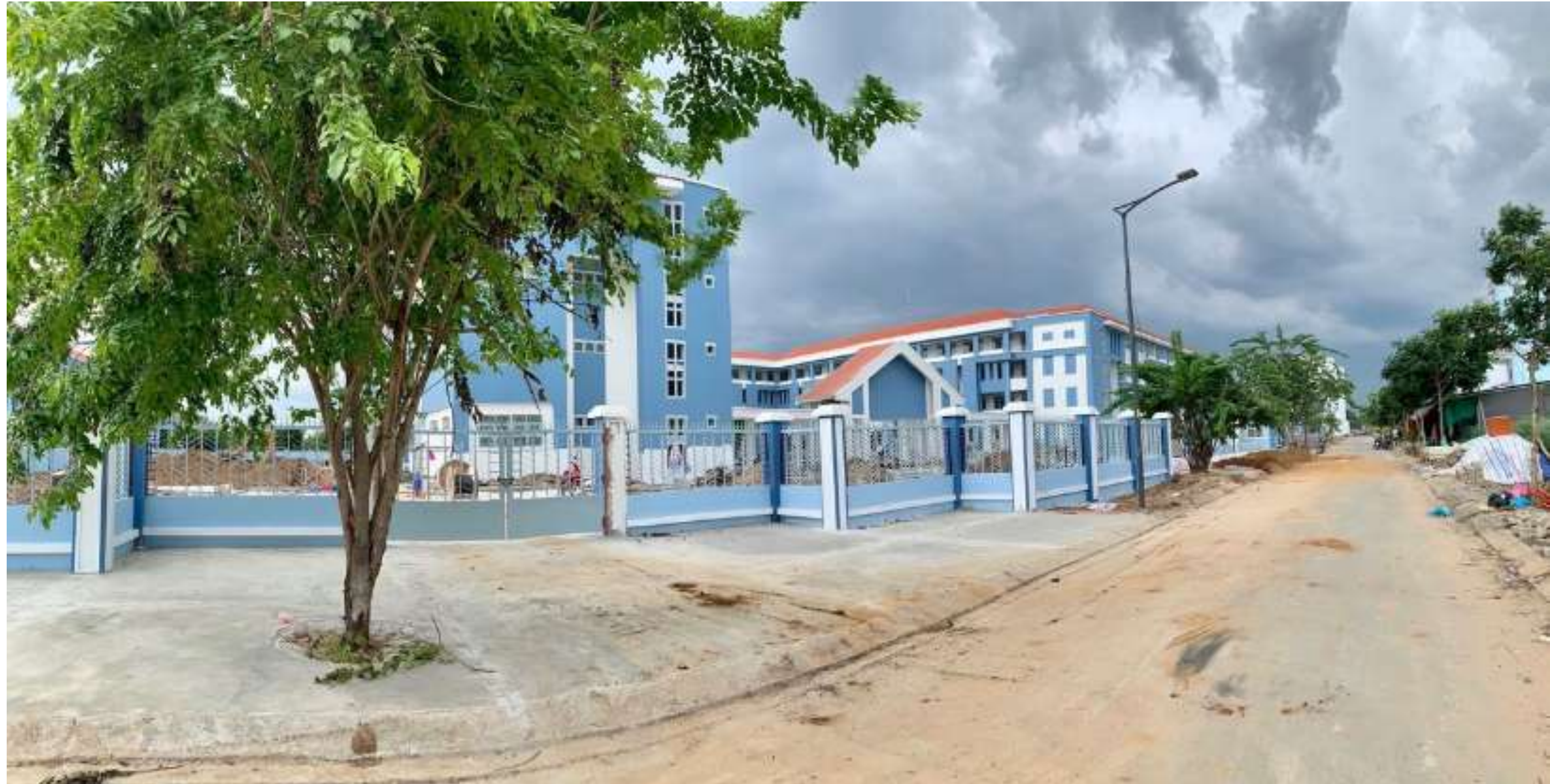
Trường Cấp 3 đang hoàn thiện
